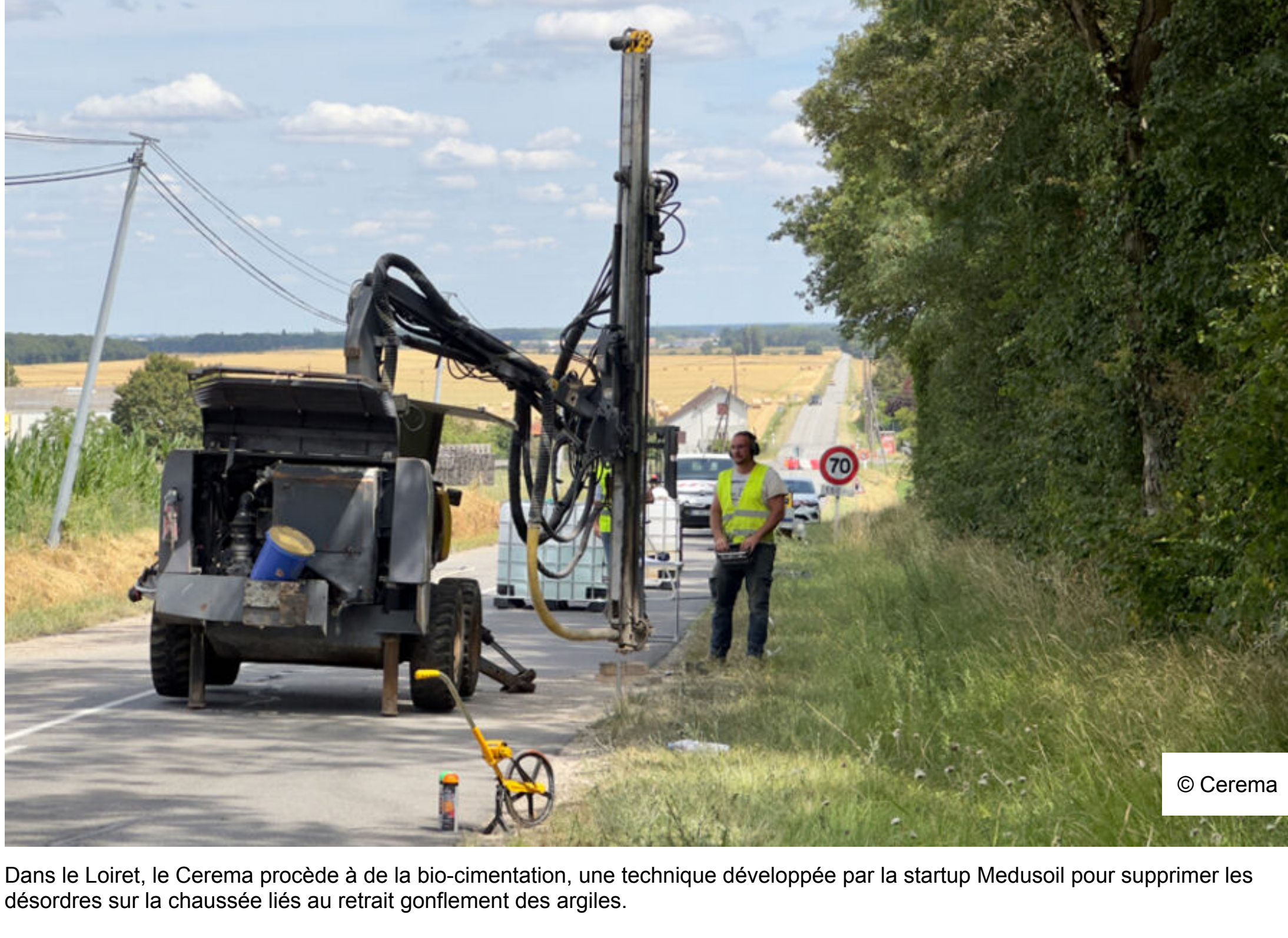
Dans le Loiret, le Cerema procède à de la bio-cimentation, une technique développée par la startup Medusoil pour supprimer les désordres sur la chaussée liés au retrait gonflement des argiles.
