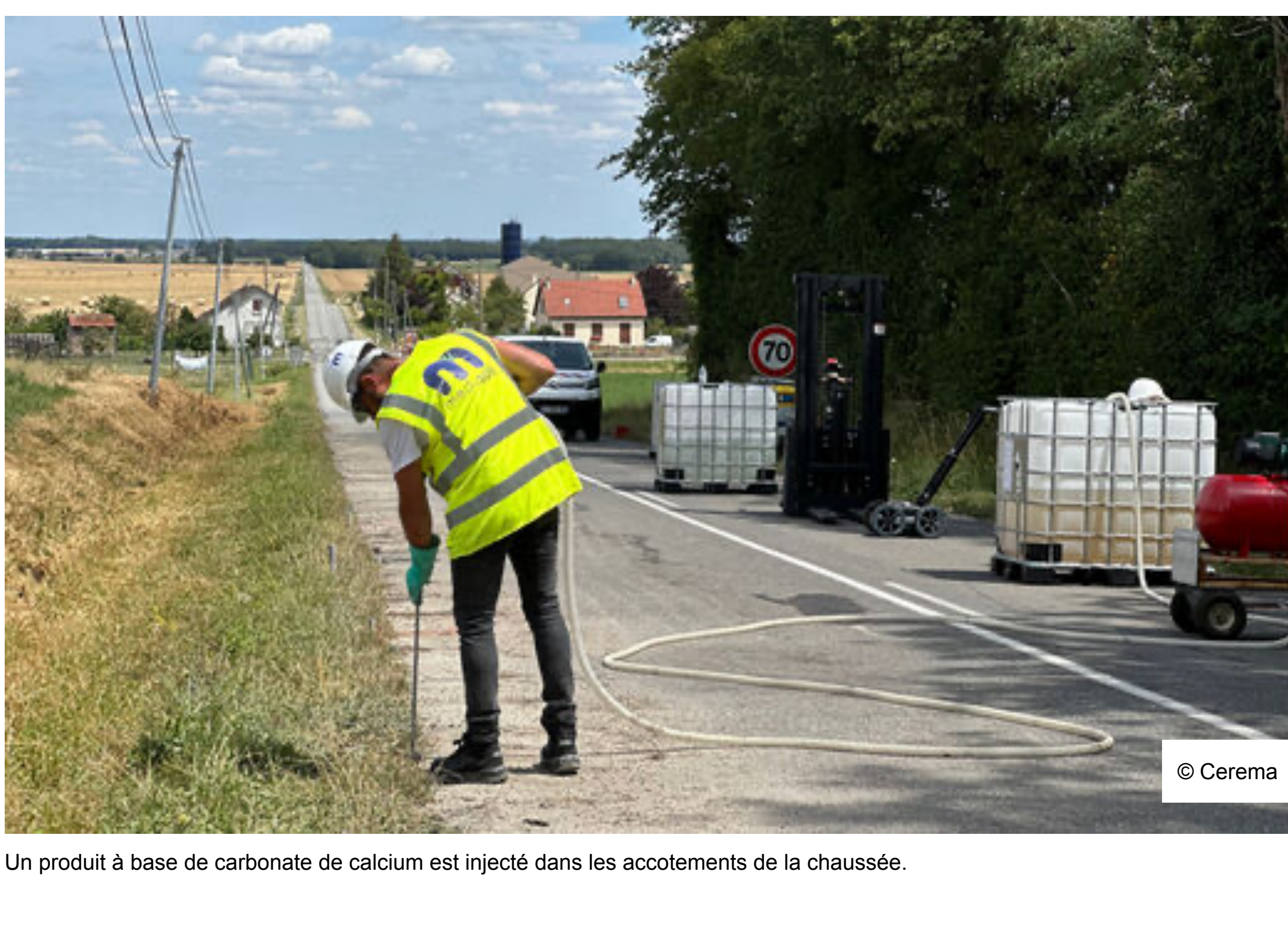
Un produit à base de carbonate de calcium est injecté dans les accotements de la chaussée.
